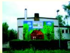
Holzbrennstoffcontainer vor der Ernst-von-Harnack-Schule in Bad Hersfeld (Foto: S. Enke)
